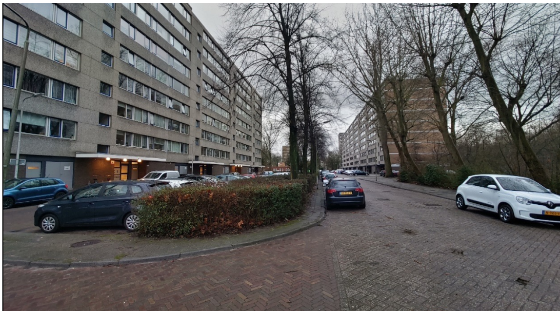
Figuur 9. Flatgebouwen aan de Roland Holstlaan waar zich de grootste gierzwaluwkolonie van het plangebied bevindt (Foto: Ecoresult B.V.).
