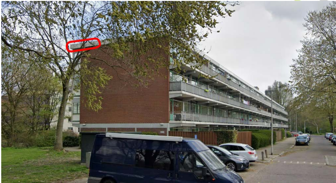
Figuur 18. Locatie kraamverblijfplaats van meervleermuis aan de Pijperring, te Delft. Foto: Google Street View.
