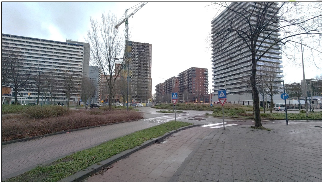
Figuur 2. Zicht op het Delflandplein met op de achtergrond het flatgebouw Delft Hoog in het centrum van de wijk Voorhof (Foto: Ecoresult B.V.).
