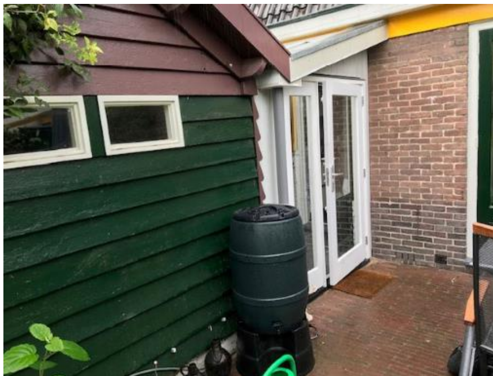
Overkapping tussen schuur en woonhuis; Vijver Zuid 20
