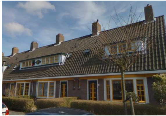
Dakramen voorzijde, éénlaagse bebouwing
