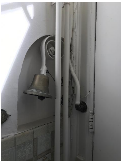
Antieke communicatie-installatie: spreekbuis en bel, Oude Delft 243
