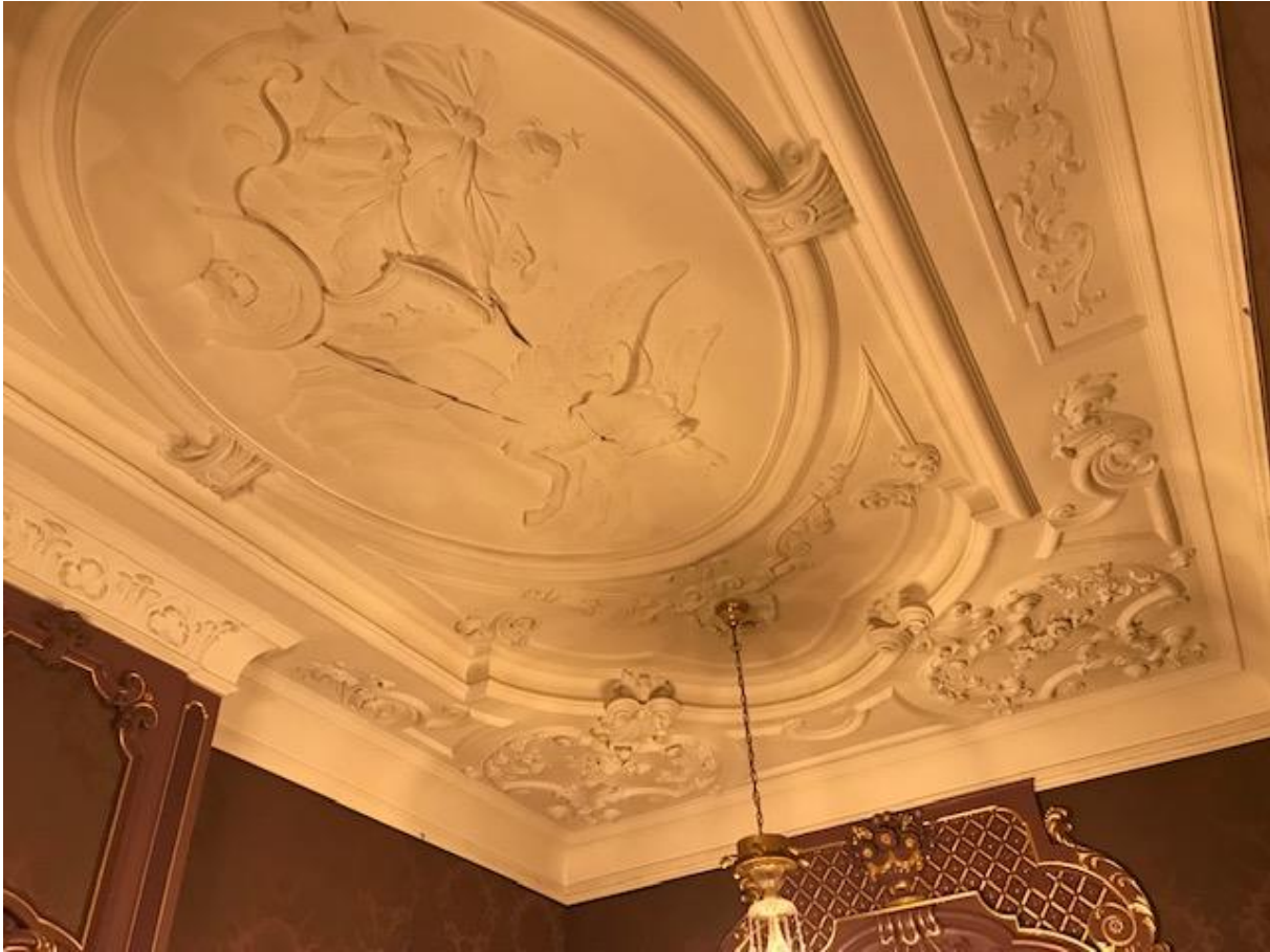
gepleisterd plafond, Koornmarkt 67
