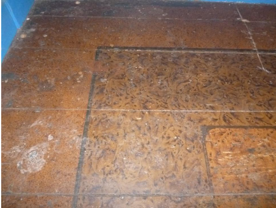
Voorbeeld van een bijzondere historische vloerafwerking; een "voetjesvloer", een afwerking die gemaakt is door kinderen met beschilderde voetjes over de houten vloerdelen te laten lopen, Oude Delft 49 (foto Wido Choufour)
