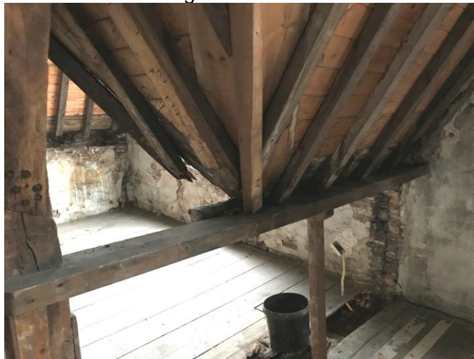
aangetaste kilgoot in een houten kap, Oude Langedijk 18a
