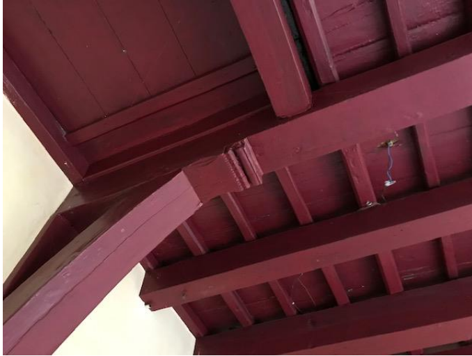
peerkraalsleutelstuk, en korbeel onder een samengestelde balklaag (moer- en kinderbinten), Barbarasteeg 7
