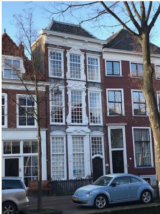
afbouwtimmerwerk kan zich zowel binnen als buiten bevinden, voorbeeld van een gevel aan de Oude Delft 34 met houten sierlijsten
