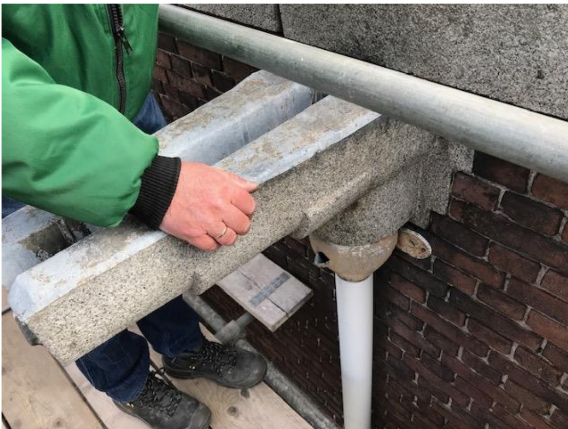
Soms komen ook goten van natuursteen voor, zoals bij dit pand aan de Mijnbouwstraat 25, waar natuursteen overstorten zijn aangebracht, bekleed met lood.
