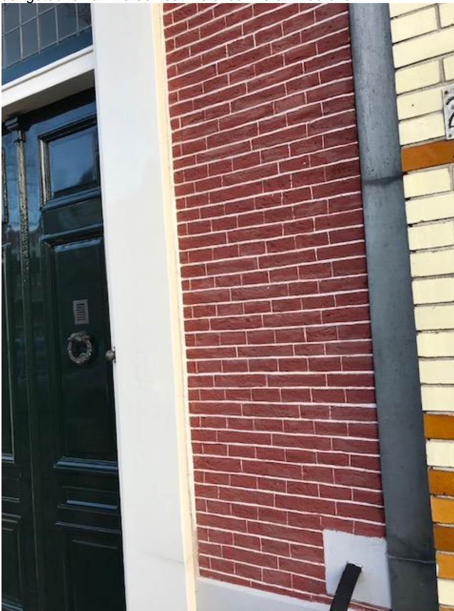
Baksteenpatroon geschilderd op stukwerk, Oude delft 210
