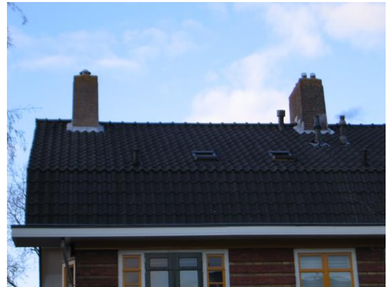
Dakraam voorzijde tweelaagse bebouwing, Trendsetter Laan van Altena 8
