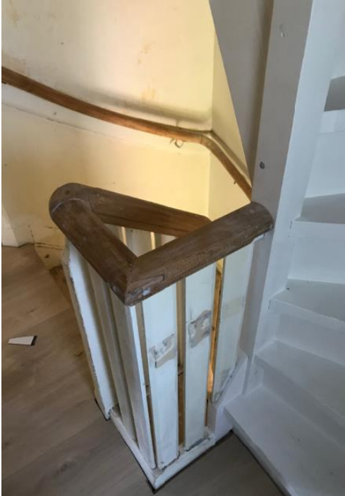
Vaste trap naar zolder recht boven de bestaande trap. Vijver Zuid 10 (voor afwerking)
