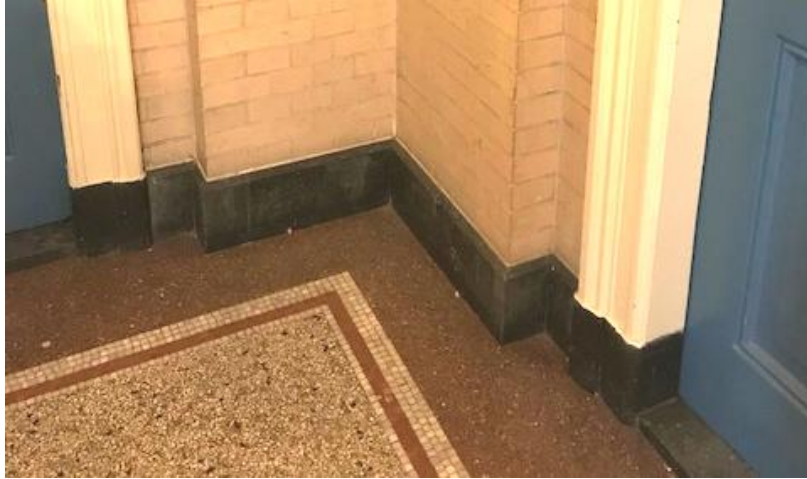
Voorbeeld van een tarrazzovloer in twee kleuren gecombineerd met mozaïektegels, Korte Geer 11 (voormalig Kantongerecht)
