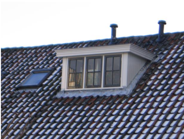
Dakkapel achterzijde Trendsetter Frederik Matthesstraat 13-15
